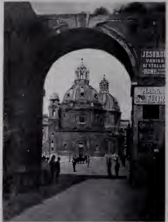
55. — Ultimo arco abbattuto del viadotto di Paolo III.
